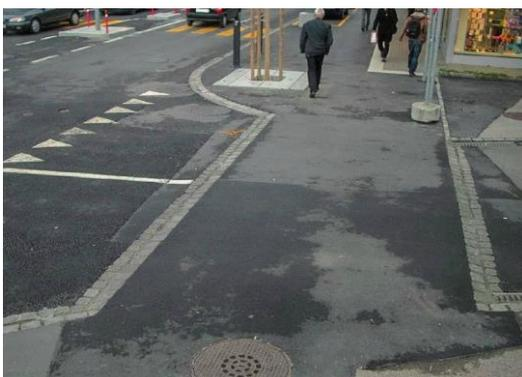
Diese Lösung entspricht weder einer Trottoirüberfahrt noch einem Vertikalversatz und darf nicht angewendet werden
