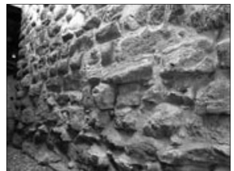
Abb. 5: Nordseitiger Sockel des neuen Turmes von 1250/51 mit Spolien aus dem alten Turm.
