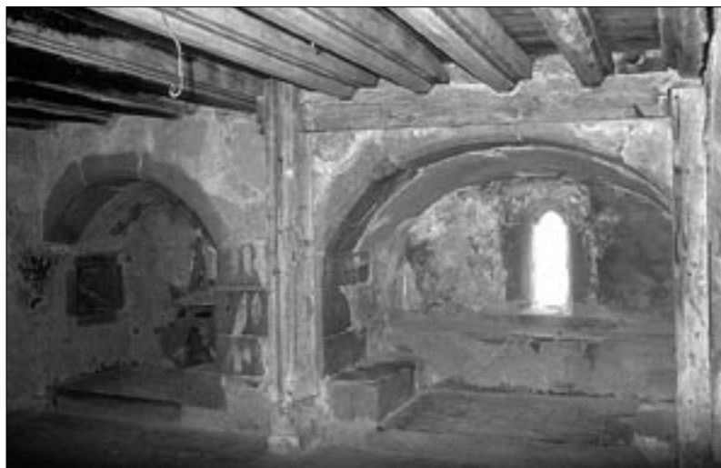
Abb. 6: Turmstube mit Bohlen-Bälkchendecke und Sitznischen von 1253.
