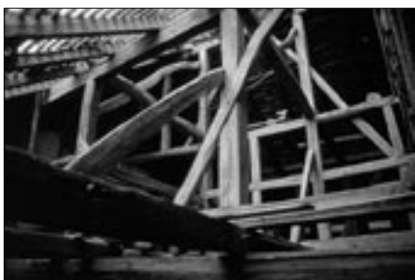
Abb. 11: Ein Zimmermannsmeisterstück: Der Dachstuhl von 1393 über dem Osthof.
