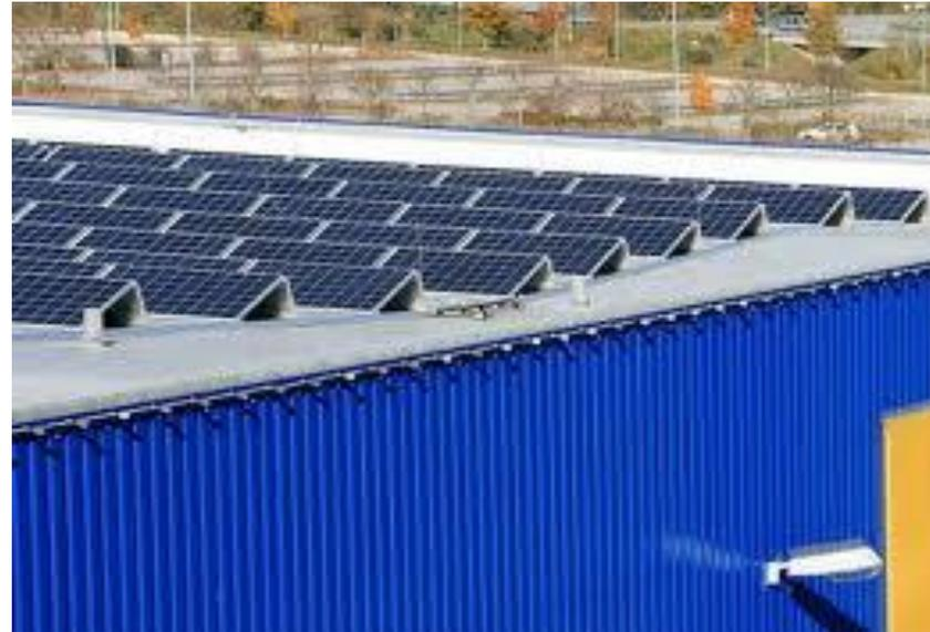
Grundsätzlich dürfen **Gebäude aufgesetzte** Solaranlagen mit einer nicht brennbaren äussersten Schicht auf Flach- oder Steildächern, welche den Brandschutzvorschriften entsprechen, **ohne weitere Brandschutzanforderungen** montiert werden.
