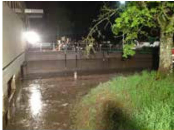
Bild 4: Überflutete Werkhof-Tiefgarage (Foto: Urs Gyseler)
