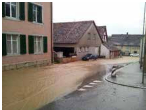
Bild 4: Überflutetes Herblingen (Abzweigung Im Höfli Blickrichtung Schlossstrasse hinunter) (Foto: Christian Egger).
