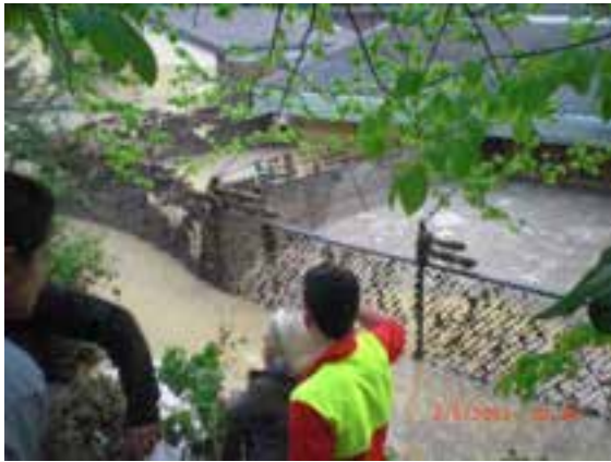
Bild 1: Hochwasserspuren beim Tierheim (Foto: Anton Renggli)
