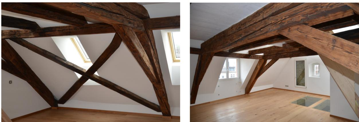
Ausgebauter Dachstock mit sichtbarer originaler Dachstuhlkonstruktion
