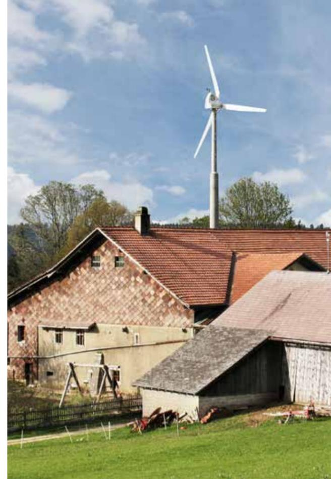
**Der Selbstversorger.** Kleinwindanlagen sind auf die Selbstversorgung ausgerichtet. Einzelne Haushalte, Bauernhöfe sowie kleinere Betriebe können ihren Strombedarf in der Regel mit einer Kleinwindanlage decken. Kleinwindanlagen produzieren Strom ab einer Windgeschwindigkeit von ca. 2,5 m/s. Die Nennleistung liegt zurzeit bei 7 bis 10 Kilowatt (kW) und wird bei 6–8 m/s erreicht. Der Rotordurchmesser kann bis zu 16 Meter betragen, das ergibt eine Turmhöhe von rund 20 Metern.
