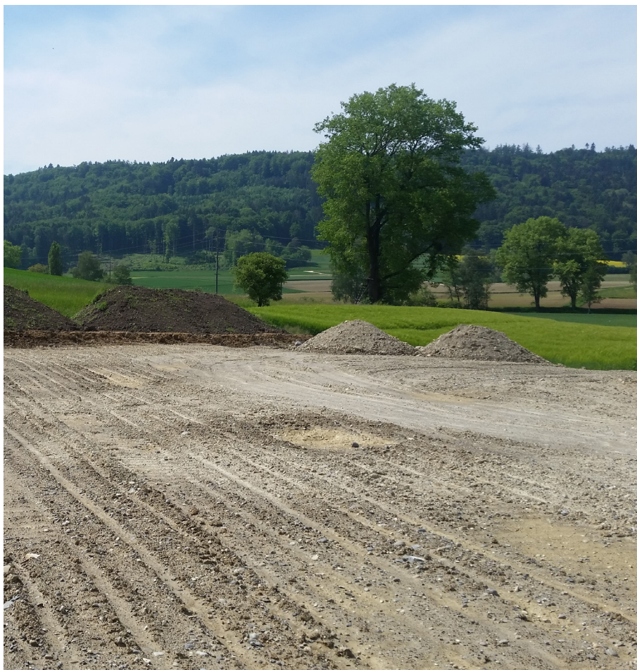
Geländeveränderung mit Aushub, Unterboden und Oberboden.
