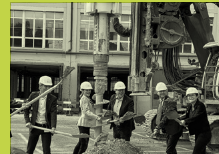
Spatenstich Kammgarn am 10. 09. 2024
