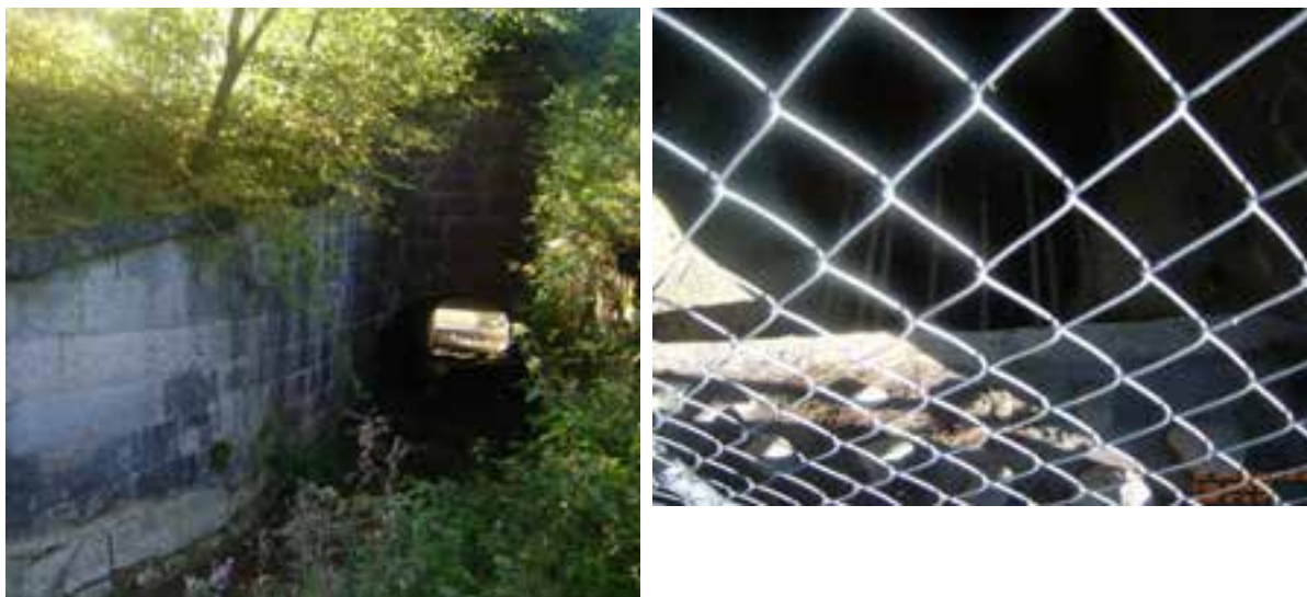
Abbildung 33: Schwachstelle Hauentalbach, QP56: Zulaufstrecke (links) zum Einlauf in die Eindolung mit Gitter (rechts)
