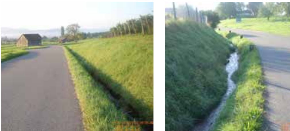
Abbildung 47: Offene Abschnitte Wingertengraben: oben mit Halbkreis-Betonschale (links), unten mit Trapez (rechts)
