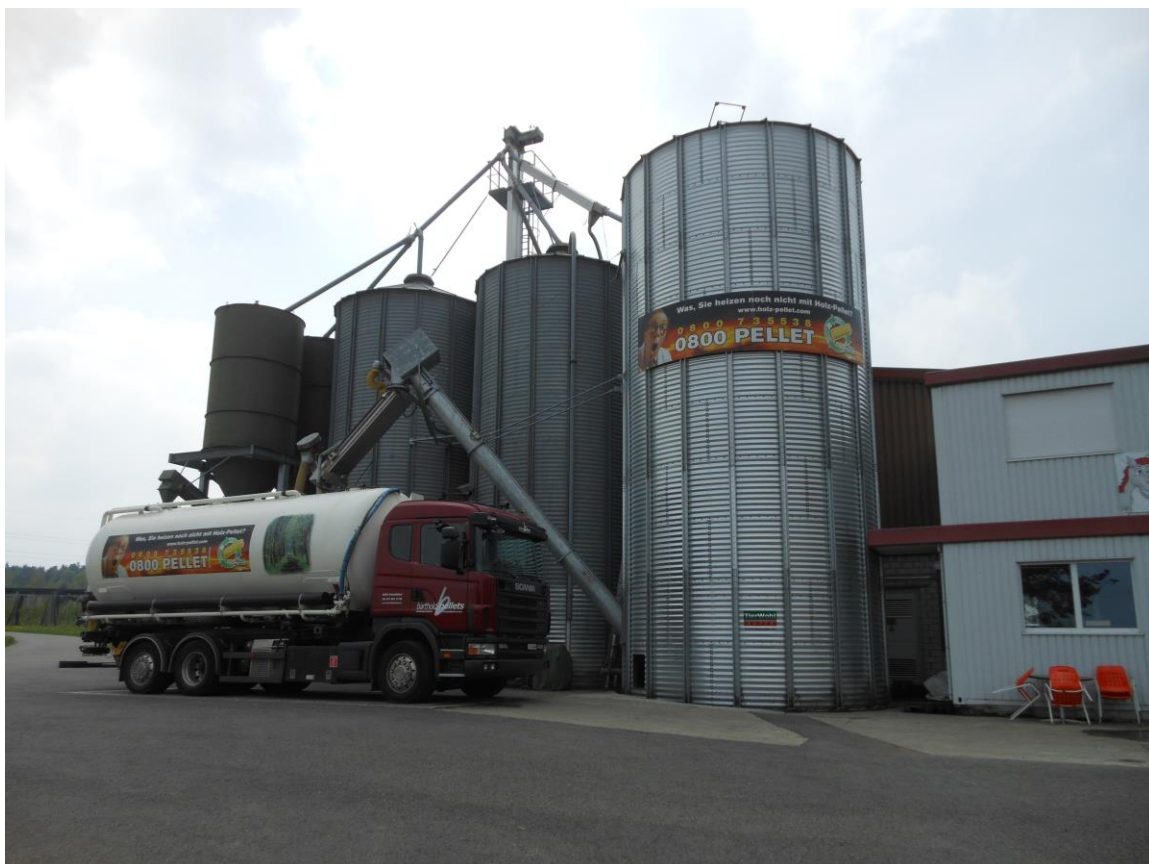
Bild 4: Die Nachfrage nach Pellets und Pelletheizungen steigt seit 25 Jahren kontinuierlich an.
