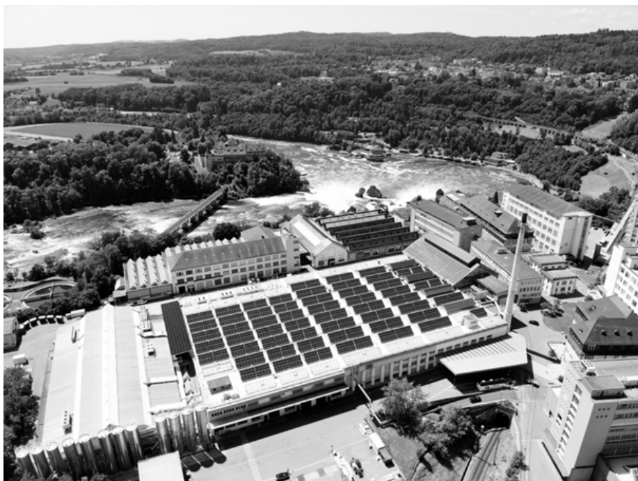
Abbildung 2: Werden grosse Dächer saniert, soll das solare Potenzial zur Stromerzeugung genutzt werden (Bild SIG Areal Neuhausen am Rheinfall, Quelle: Reasco Immobilien AG, Projekt- und Bauleitung, Energieberatung).
