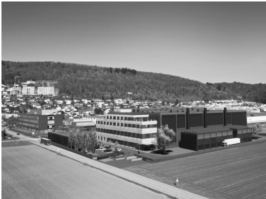
Abbildung 1: Für grosse Energieverbraucher mit viel Abwärme (im Bild Fotomontage des neuen Datenzentrums in Beringen, Quelle: Stack Infrastructure) sollen zusätzliche Anforderungen bezüglich Energieeffizienz, erneuerbare Stromerzeugung und Abwärmenutzung gelten.
