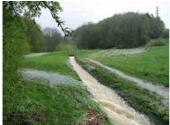
Abb. 5.11: Der Herblinger Dorfbach beim Schützenhaus entgegen der Fliessrichtung (Foto Kt. SH, 3.5.2013). Gut sichtbar sind die Spuren des überströmten Regenrückhaltebeckens im Hintergrund. Aufgrund der Spuren im Vordergrund konnte eine Abflussspitze von 3 – 3.5 m<sup>3</sup>/s abgeschätzt werden.
