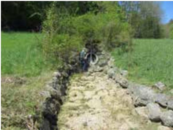
Abb. 5.10: Regenentlastung aus dem Siedlungsgebiet von Stetten in das Regenrückhaltebecken des Herblinger Dorfbachs am 8.5.2013. Gut sichtbar sind die Spuren der Entlastung vom 2.5.2013.
