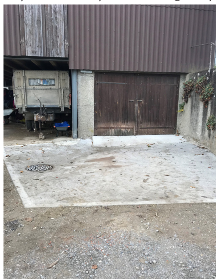
Positivbeispiel: neu erstellter Diesel-Betankungsplatz
