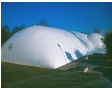
Abb. 1: Überdachung Schwimmbecken (Länge 58 m, Breite 28 m, Schaffhausen, Kosten ca. ½ Mio. CHF) 1,2
