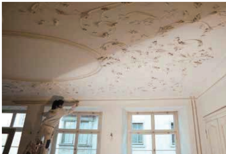
Renovation der Tanne 7, Schaffhausen: Die Denkmalpflege betreut laufend mehrere Wohnbauprojekte in Städten Stein am Rhein, Neunkirch und Schaffhausen. Dabei wird neuer Wohnraum geschaffen, ohne den Altstadtcharakter zu beeinträchtigen.
