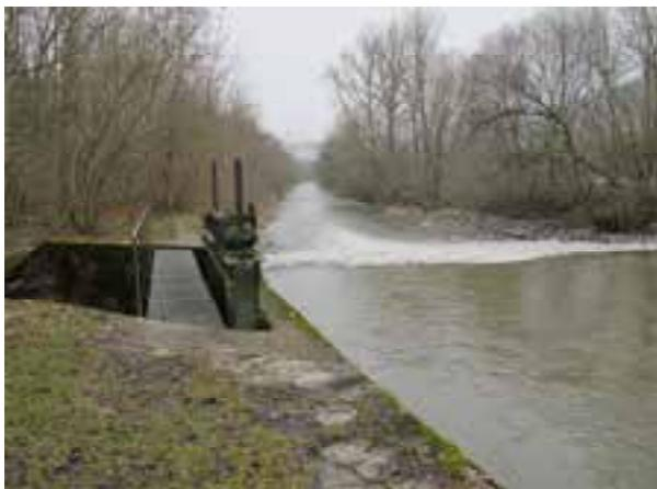
Abb. 10: „Gononwehr“ mit linksufriger Ausleitung
