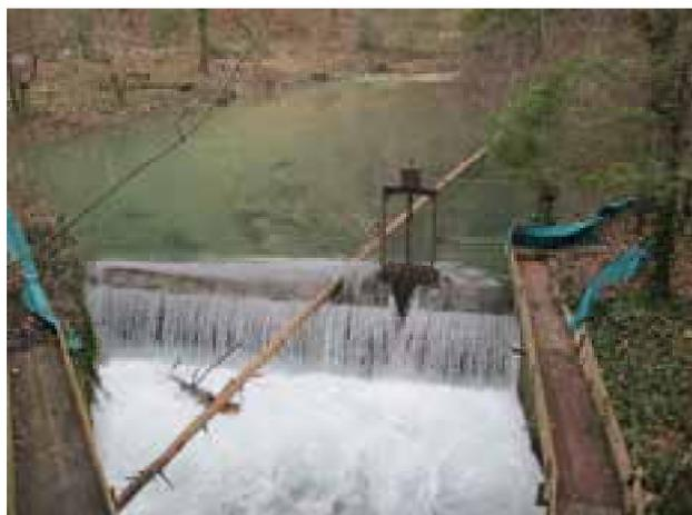
Abb. 14: Betonabsturz mit ca. 120 cm Fallhöhe
