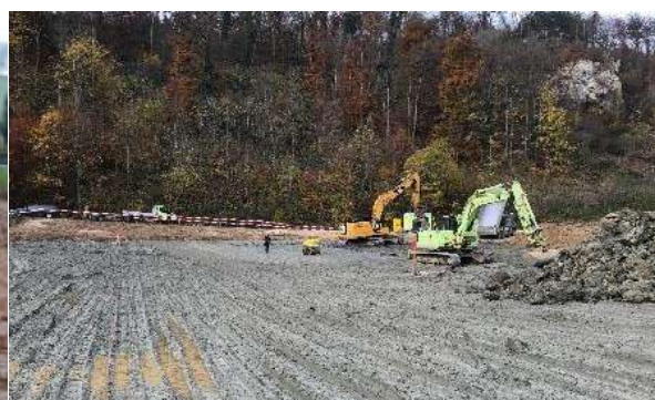
Flachweiher wird erstellt, siltiges Gletschermaterial in Umgebung verteilt und 3-schichtig Lehm eingebaut (Fotos: P. Bachmann)
