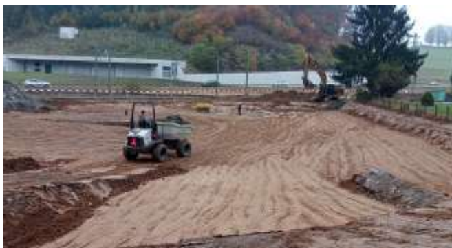
Flachweiher wird erstellt, siltiges Gletschermaterial in Umgebung verteilt und 3-schichtig Lehm eingebaut (Fotos: P. Bachmann)
