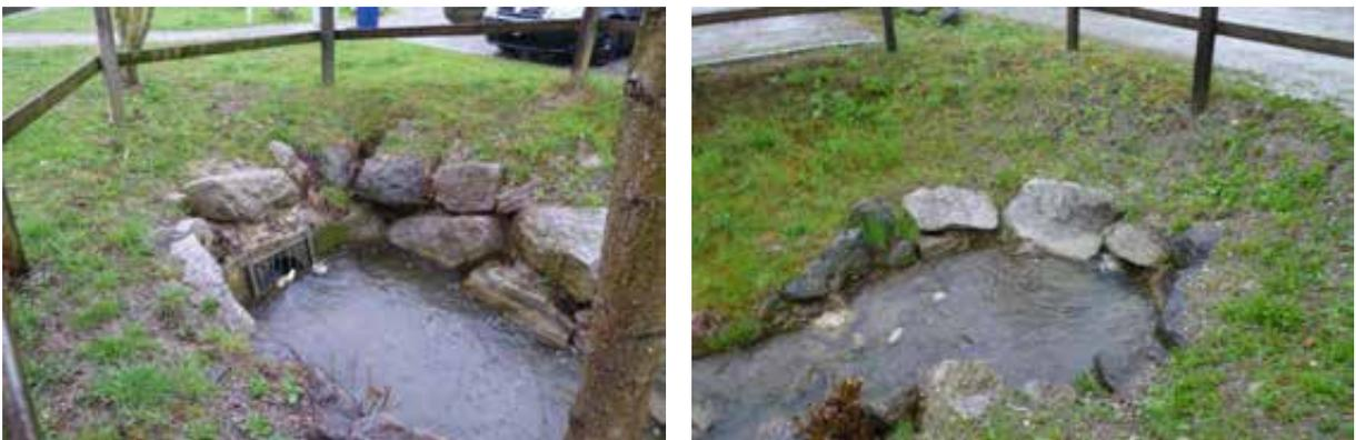
Abbildung 41 Schwachstelle Mülibach QP628, Eindolung (links) und Auslauf der oberen Eindolungsstrecke mit dem tief liegenden Auslauf.
