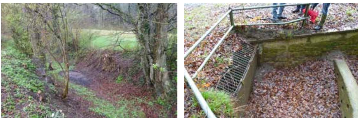
Abbildung 44 Wiesholzgraben, Abschnitt oberhalb QP612 (links) und einer der weiter oberhalb liegenden Geschiebesammler am Waldrand
