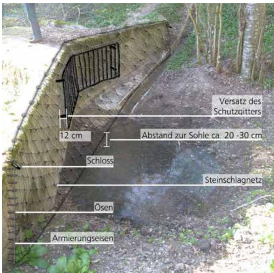
Abbildung 26 Optimierter Einlaufrechen mit vorgeschaltetem Schwemmholzrechen
