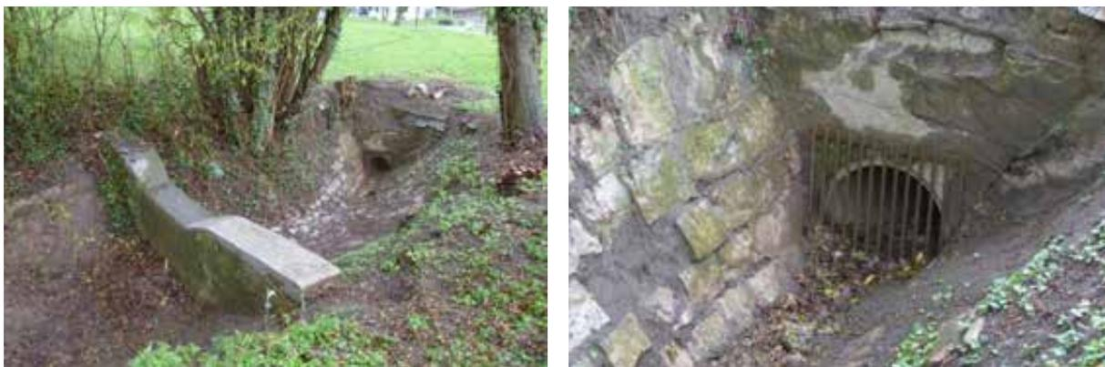
Abbildung 43 Schwachstelle Wiesholzgraben QP612, Eindolung mit vorgelagerter Betonsperre und Rechen
