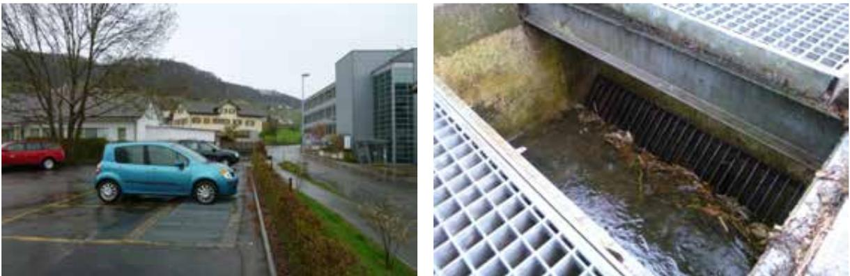
Abbildung 40 Schwachstelle Mülibach QP627, Ansicht der Schwachstelle mit Abdeckgitter (links). Das entfernte Abdeckgitter gibt den Blick auf den feinen Rechen (Zulauf zum Schachtbauwerk) frei (rechts).
