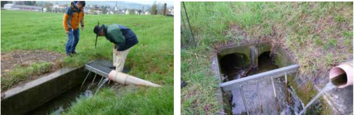
Abbildung 39 Schwachstelle Mülibach QP615 und QP621 mit der verzweigten Eindolung, dem Rechen und den Halterungen für die Regulierung bzw. die Staubretter der Feuerwehr.
