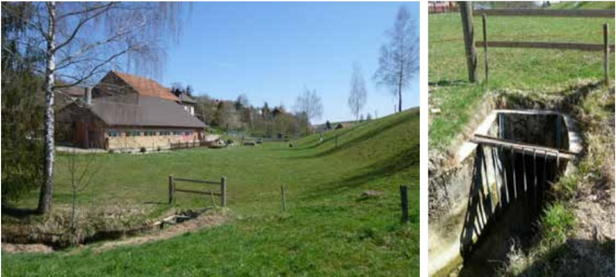
Abbildung 36 Schwachstelle Wäschbach QP122, Eindolung mit Detailaufnahme des Rechens
